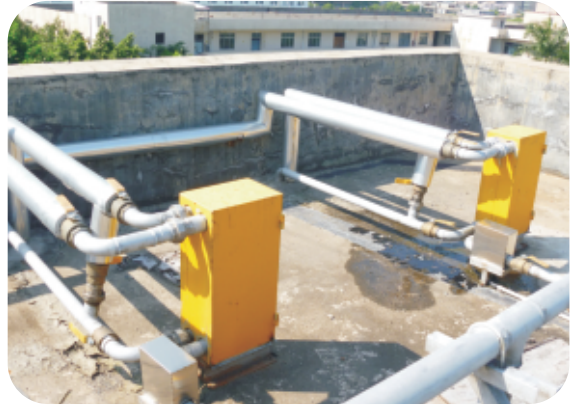
圖：3.21 空壓機熱交換器
