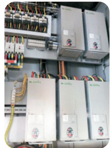
圖：3.8 空調系統的變頻器
