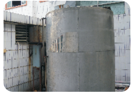
圖：3.17 熱交換儲水缸
