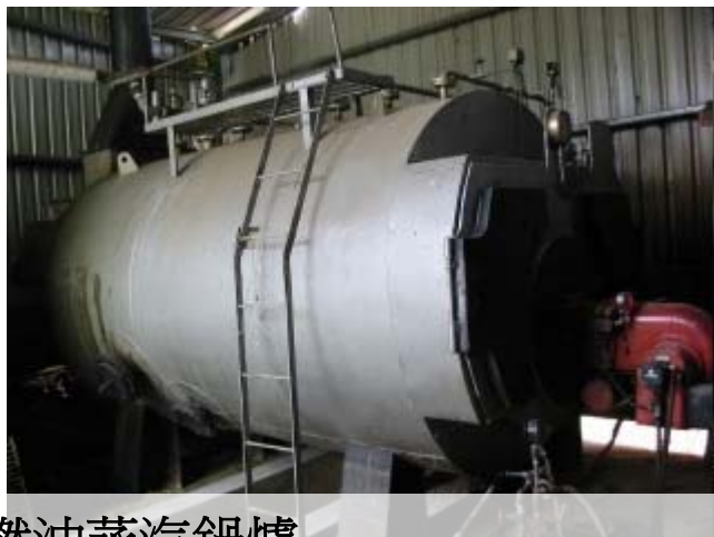
燃油蒸汽鍋爐 (產生蒸汽以加熱的蒸煮槽內廚餘)
