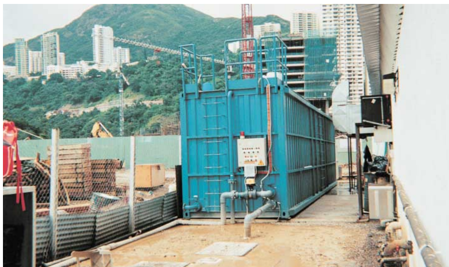
HKPC-Kititreat 處理建築地盤廚房污水，以全自動化模式將有機污染物分解。
